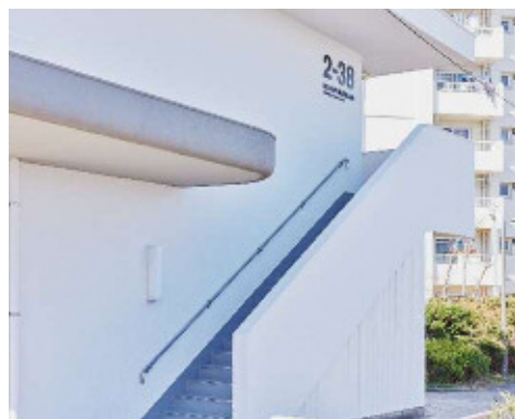
商店街施設棟の外壁
